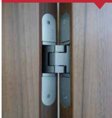
Detail skrytého pantu
