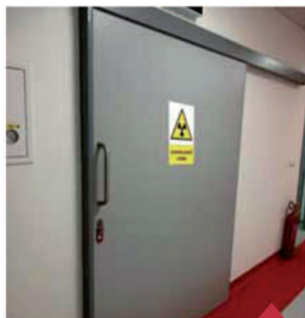
Realizace dveří s olověnou vložkou
